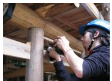
板を留める下地を軸組 みに取り付けます。
