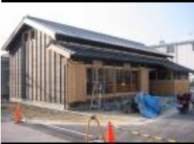
2003 香住古民家移築
