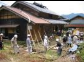
2002 大飯古民家移築
