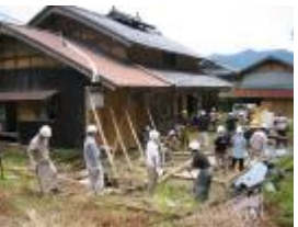
2002 大飯古民家移築
