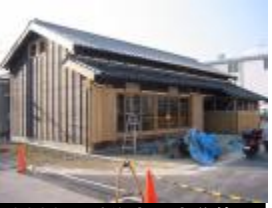
2003 香住古民家移築
