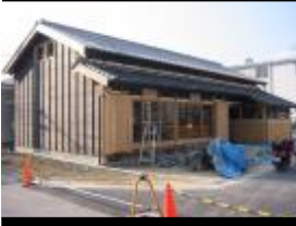
2003 香住古民家移築
