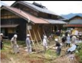
2002 大飯古民家移築
