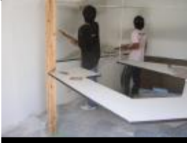
2007 西武庫団地リフォーム
