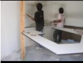
2007 西武庫団地リフォーム
