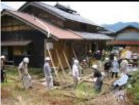
2002 大飯古民家移築
