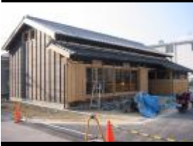
2003 香住古民家移築
