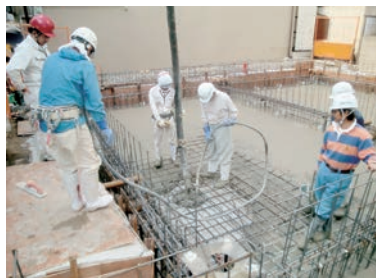
「事務所ビルコンクリート打設」
