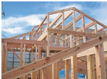
「大工が手刻みした紀州熊野材での上棟風景」
