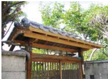
『門屋改修工事』2014年
