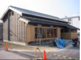
2003 香住古民家移築
