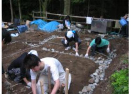
“根切”が終われば、掘削した底にこぶし大の石を敷き詰め、“タコ”と呼ばれる手製の道具で転圧します。建物の全荷重を地面に伝える部分ですので、工事は念入りに進められます。
