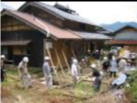
2002 大飯古民家移築
