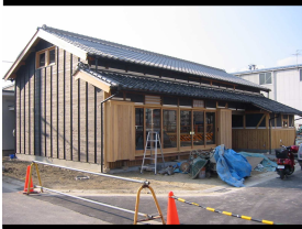
2003 香住古民家移築
