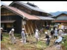
2002 大飯古民家移築
