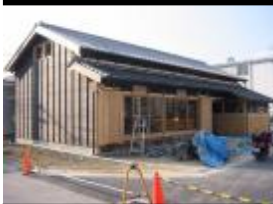
2003 香住古民家移築
