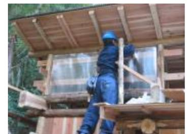
小屋の壁には、採光の為にポリカ-ボネートの中空板を張りました。丸太の束や梁の内面に張りますので、下地の角棒を固定してから、一枚一枚形を合わせてビスで取り付けます。ガラスに比べて、簡単に切断が出来て、アクリル板のような変色も少ない優れた材料です。
