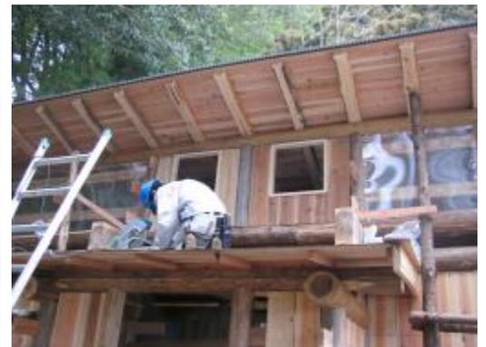
小屋壁の開口枠。右は換気用、左は煙突用です。何気ない枠ですが、各角の直角精度や壁からの出寸法(チリ)等、考える要素は結構あります。
