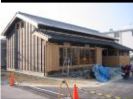
2003 香住古民家移築
