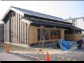
2003 香住古民家移築
