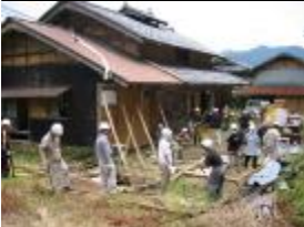
2002 大飯古民家移築
