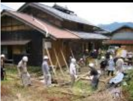
2002 大飯古民家移築
