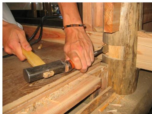
2年生が先行する造作工事。畳寄せや建具枠は、柱や梁などの構造材との取り合いや、ボードや仕上げ板との関係を見越した上で加工や取り付けをします。完成後の姿や加工手順が理解しきれていない1年生には荷の重い作業ですが、チャレンジあるのみです。
