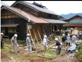
2002 大飯古民家移築
