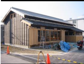
2003 香住古民家移築
