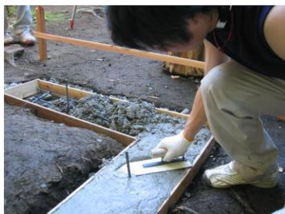
コンクリートは硬めに練って、型枠内にしっかり充填するように打設することが大事。ブロックは基準の水糸に沿わせて水平に並べます。接着剤代わりのモルタルの硬さを調整しながら慎重に、丁寧に。
