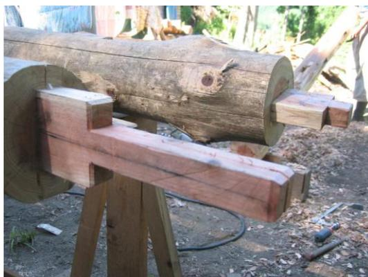
柱4本と桁梁4本で組み立てられる給水塔ですが、上の重ねホゾをはじめ、高度な仕口が用いられています。金物や筋交いでガチガチに固めたフレームではなく、木と木を組み合わせたネバリ強いフレームを目指しています。
