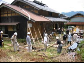
2002 大飯古民家移築
