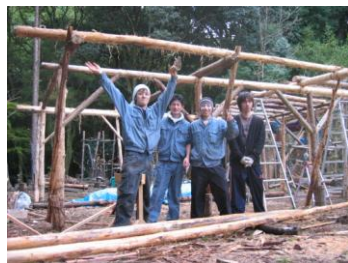
2008.11 作業小屋作り
