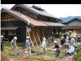
2002 大飯古民家移築
