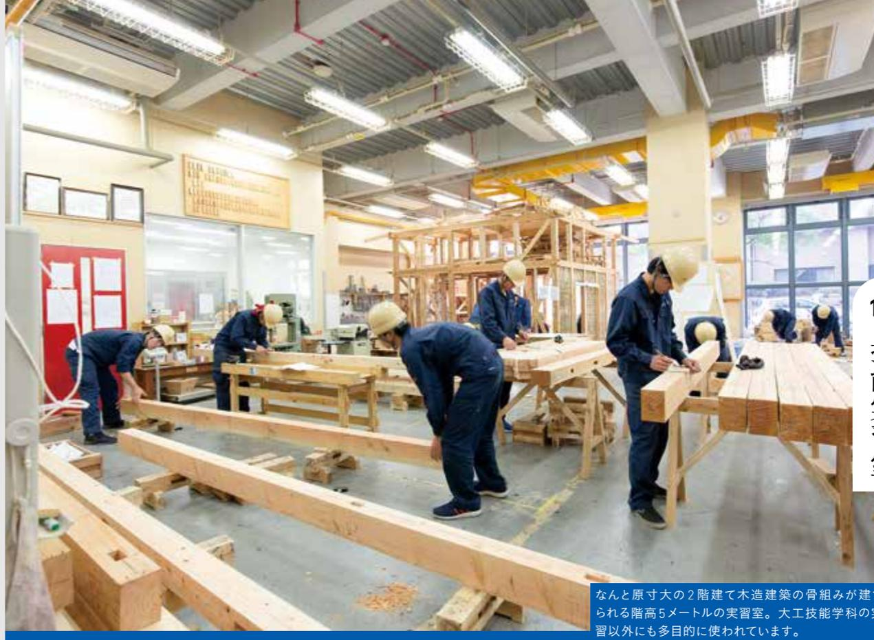
なんと原寸大の2階建て木造建築の骨組みが建てられる階高5メートルの実習室。大工技能学科の実習以外にも多目的に使われています。
