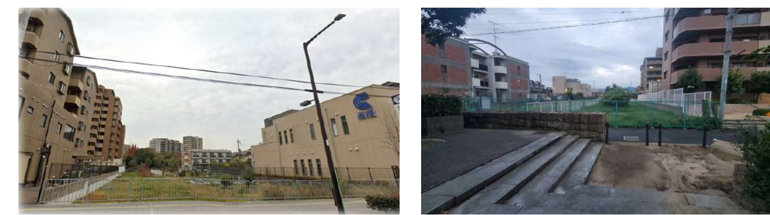
前面道路から撮った現状写真
