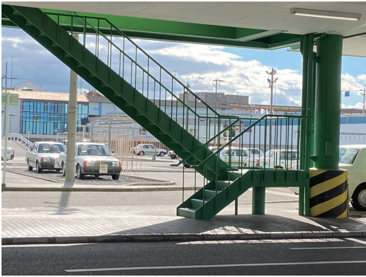
校舎の階段がステア(階段)に似ている。
