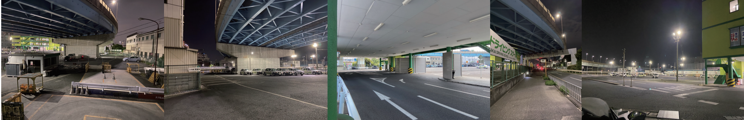
空いているスペース
